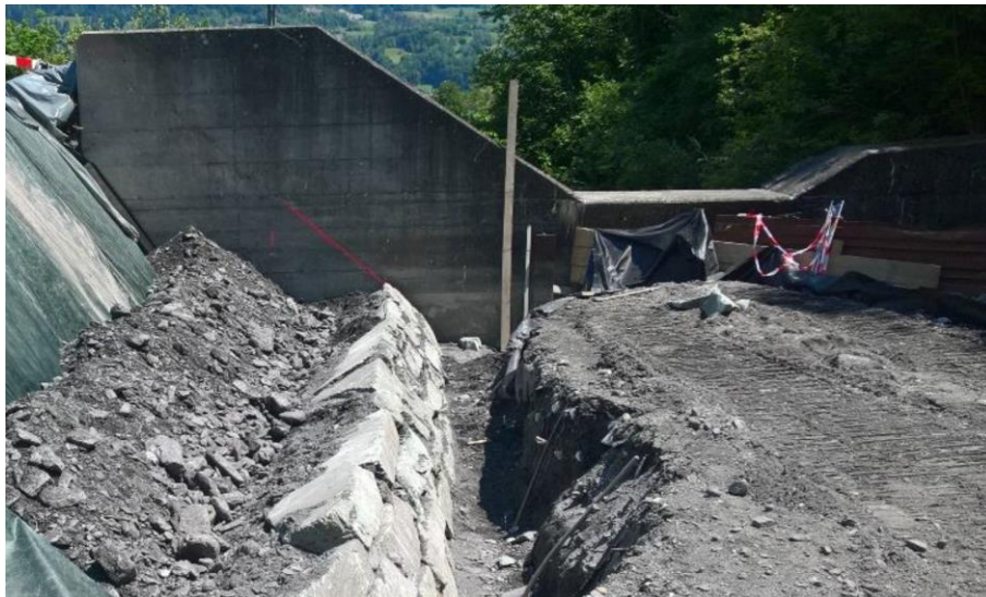
Figura 3: diga di terra e rocce / pista per l'escavatore costruite per prosciugare una stazione di Poligono. In fondo a destra nella foto si vedono le palancole utilizzate per restringere temporaneamente il letto del fiume. Nella metà destra della foto si nota la pista per autocarri ed escavatori che poggia sopra un telo in tessuto-non-tessuto contro le erbe infestanti. Per evitare una diffusione ulteriore della pianta, una volta terminati i lavori tutto il materiale è stato smaltito in una discarica. Il muro in blocchi di pietre è attualmente di nuovo in fase di realizzazione. Esso include anche uno strato di materiale di sedimentazione depositato sopra un telo in tessuto-non-tessuto contro le erbe infestanti Plantex Platinum. (Foto: Beni Bau AG, 2017)
