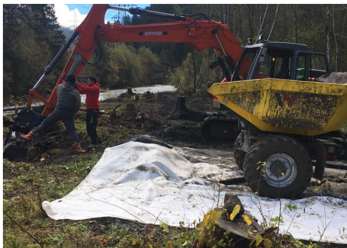
Figura 4: un telo in tessuto-non-tessuto è stato steso durante le operazioni di carico per raccogliere le zolle di terra che cadono regolarmente sul terreno circostante. (Foto: Ufficio per la natura e l'ambiente, 2017)
