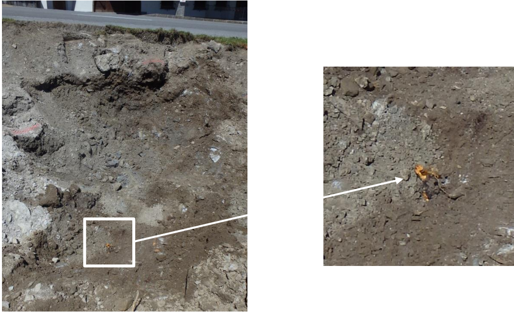
Figura 1: un ultimo rizoma, rimasto nel punto più profondo dello scavo, si sviluppa in profondità. Sembra che abbia dato origine al nucleo che poi, in superficie, ha infine occupato una superficie molto maggiore. A causa della presenza di varie condotte e canalizzazioni, non è stato possibile rimuovere completamente questo rizoma. È stato quindi circondato con un robusto telo in tessuto-non-tessuto contro le erbe infestanti e ricoperto con del materiale pulito. (Foto: Ufficio per la natura e l'ambiente dei Grigioni, 2015)
