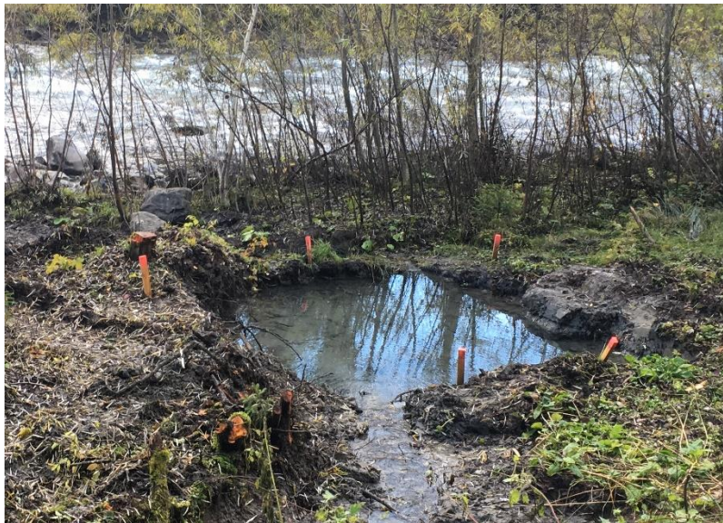
Figura 2: paletti di legno marcati con colori al neon che, durante i lavori di asportazione del suolo, sono stati utilizzati per indicare la superficie misurata di un nucleo di Poligono insieme alla distanza di sicurezza. (Foto: Ufficio per la natura e l'ambiente, 2017)
