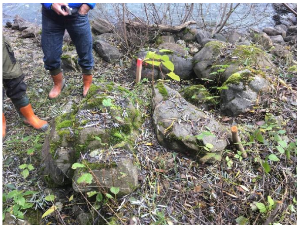
Figura 14: la presenza di grosse pietre o anche l'apparato radicale di un albero possono causare notevoli problemi durante l'asportazione del suolo. A differenza delle radici, che nella maggior parte dei casi vengono inviate a un impianto di incenerimento, le pietre devono essere ripulite dal materiale terroso di scavo rimasto loro attaccato e depositate temporaneamente in un luogo adatto nel caso in cui, una volta terminati i lavori, siano rimesse di nuovo dove si trovavano all'inizio (p. es. pietrame da scogliera o pietre da costruzione). (Foto: Ufficio per la natura e l'ambiente dei Grigioni, 2017)
