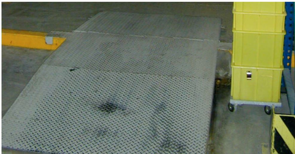
Durch geeignete Übergänge kann bei fest eingebauten Installationen ein hindernisfreier Betrieb sichergestellt werden.
