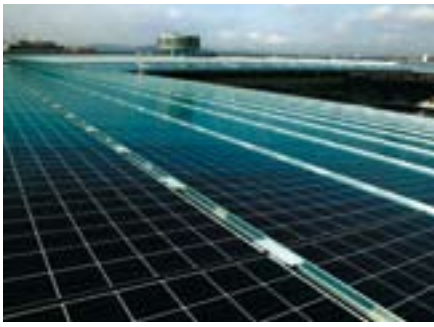
Capteurs solaires sur le toit du nouveau stade du Wankdorf, à Berne : les énergies renouvelables ont de l'avenir.
